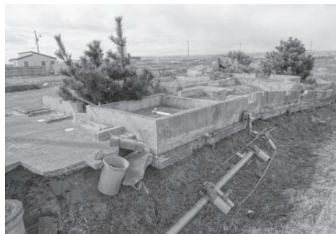
荒浜地区の住宅基礎群
