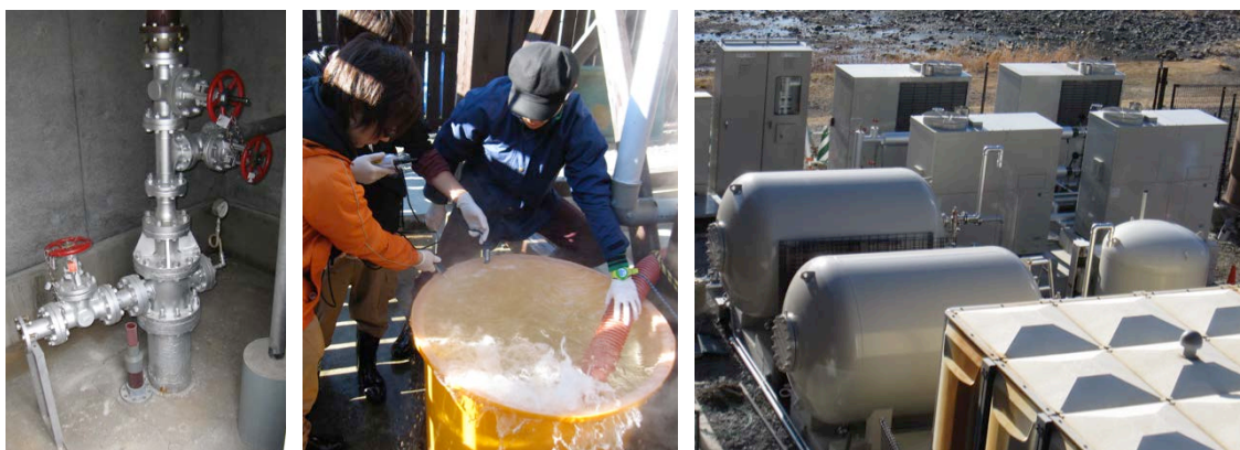
写真：川根温泉の掘削井（左）、地下温水（温泉）と付随ガス（中央）、温泉メタンガス発電施設（右）
