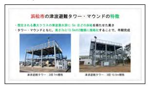
浜松市の特徴ですが、想定される最大クラスの津波浸水深に 5m 程の余裕を持たせた高さを有しておりまして、2段7mと3段10.5mの2種類に規格化することで早期完成が可能になったと思われます。
