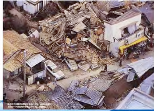
1995年1月17日 阪神・淡路大震災 木造住宅の倒壊(芦屋市)で多くの犠牲者が
